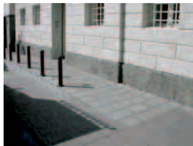
Biblioteca, rampa esterna
