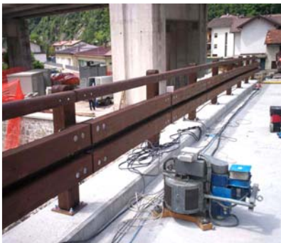
Posizione della vibrodina e degli accelerometri
