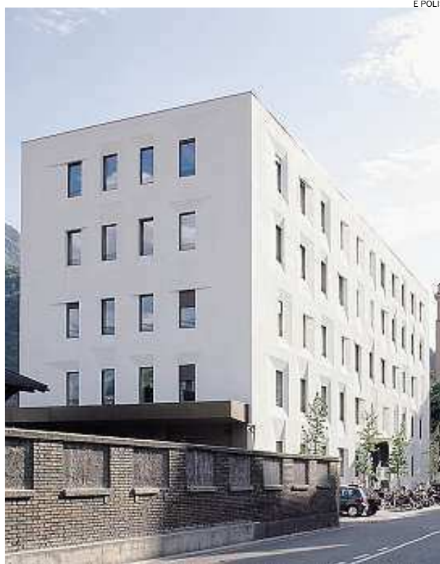
► Illustrata al convegno la ristrutturazione ex Post di Bolzano
